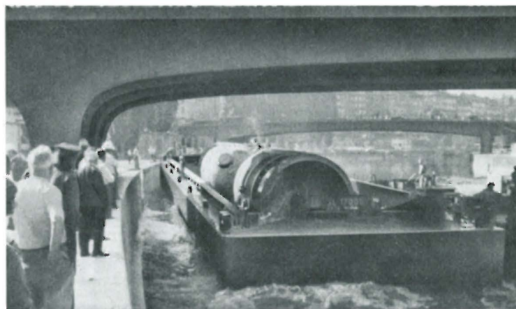
Ein Schwertransport im Donaukanal bei der U-Bahn-Baustelle
