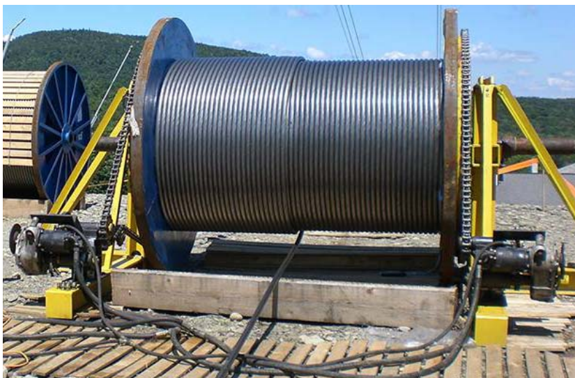
Abbildung 101: Kantholz als Anlaufschutz beim Einziehen eines Seils (Quelle: zurbrugg.ch)
