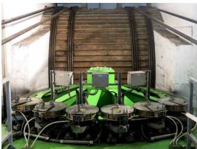
Liegender Pendelbahnantrieb mit einfacher Umschlingung
