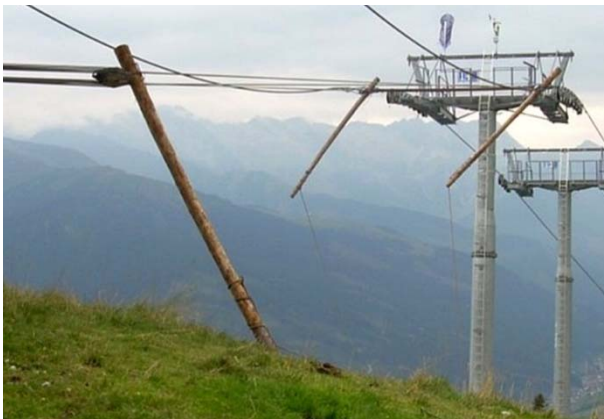
Abbildung 19: Drehmomentstützen bei der Montage eines Sesselbahnförderseils (Quelle: seilbahnen-kogler.at)
