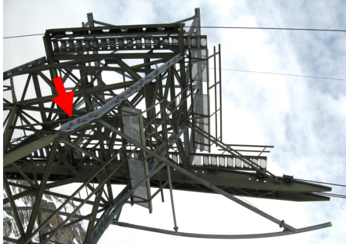
Abbildung 100: Aussteifungsmaßnahmen an einer bestehenden Stütze
