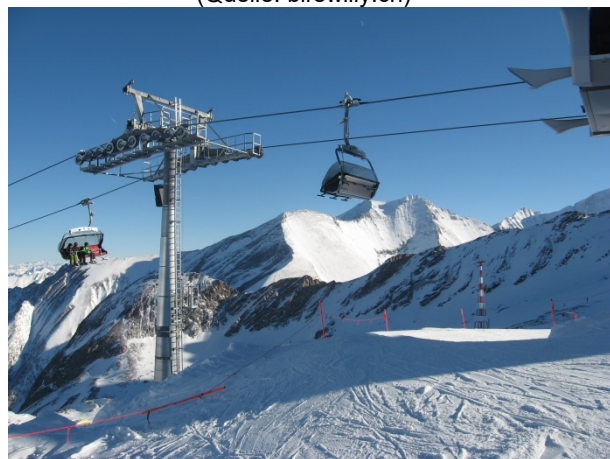
Bergstation mit langem Stützenabstand
