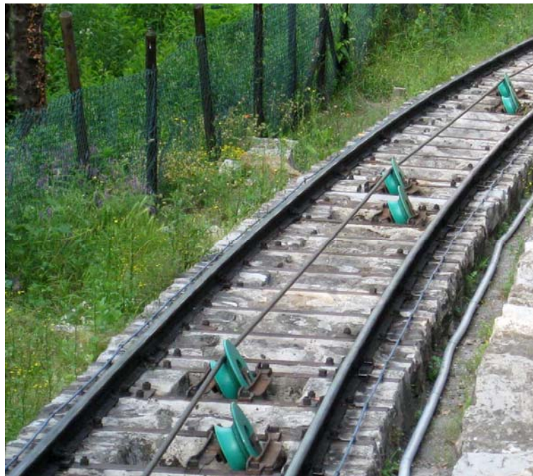
Abbildung 73: Kunststoffführungsrollen zur Minderung von Seildrehung in Lugano
