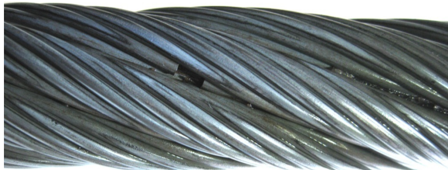
Abbildung 15: Drahtbruch an der Litzengasse eines aufgedrehten Zweiseilpendelbahnzugseils
