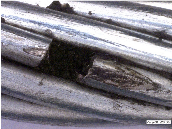
Abbildung 39: Abschürfung mit Drahtbruch im Bereich der ehemaligen Litzengasse des aufgedrehten Seils
