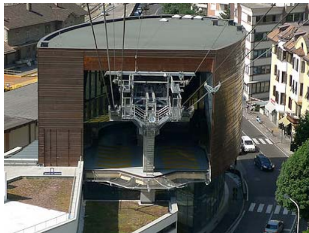
Talstation einer 3S-Bahn mit integrierter Stütze (Quelle: birswilly.ch)
