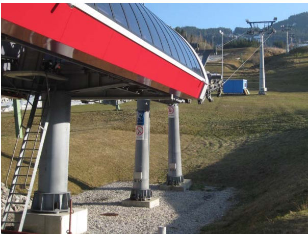
Talstation mit separaten Stützenfundamenten
