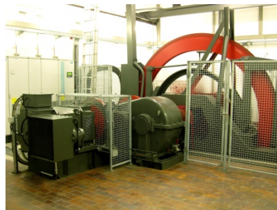
Stehender Pendelbahnantrieb mit einfacher Umschlingung
