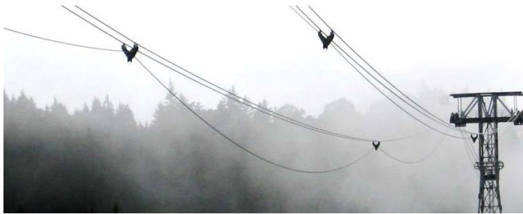
Abbildung 97: Beispiel eines zu langen unteren Zugseils bei Abspannung am Berg; die großen Durchhänge bei verminderter Seilspannung können Drall begünstigen
